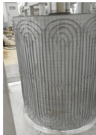
图 26: 久盛电气应用在熔盐泵上的电伴热产品
