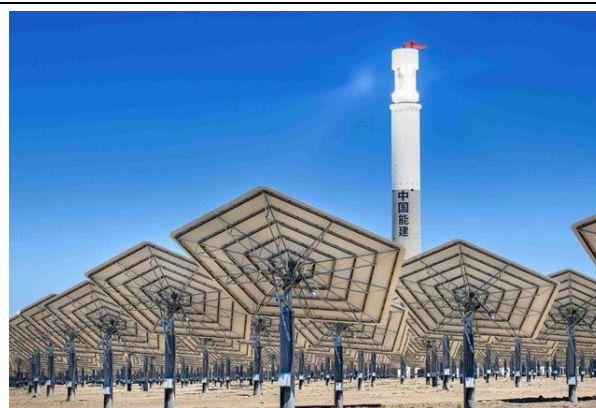
图 11：哈密 50MW 项目定日镜支架结构
